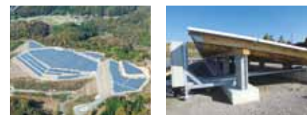
佐用・IDEC 申山太陽光発電所 再利用可能な木製の架台を使用
