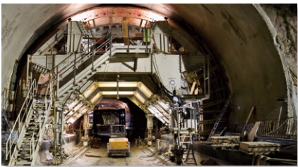
工事現場で使用するタブレットに安全をプラス
