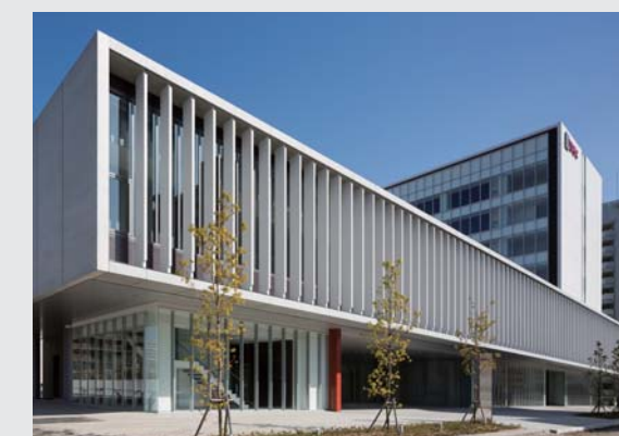
IDEC本社/技術研究センター
