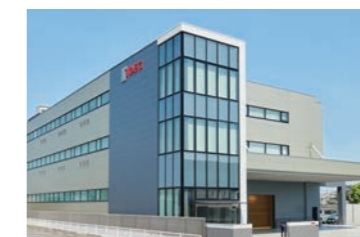
新工場(2021年4月稼働)
