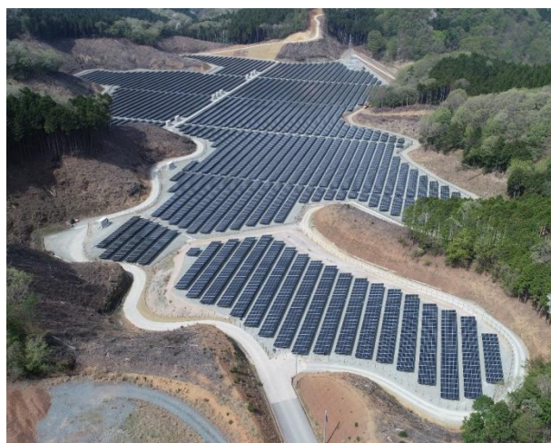
佐用・IDEC 秀谷太陽光発電所
