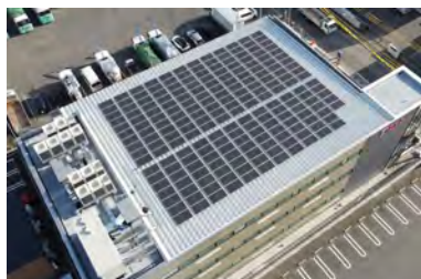
屋上に設置した太陽光パネル
