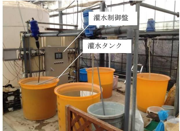
図2 灌水制御盤と灌水タンク
